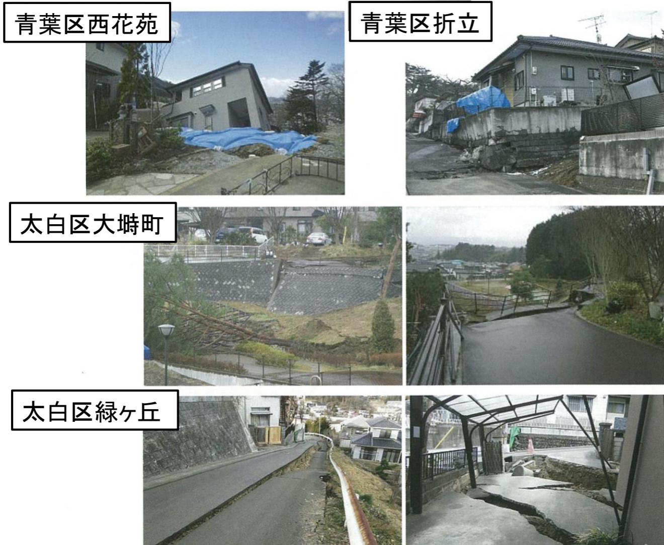
写真1 盛土造成地の滑動崩落の状況 (出典:仙台市ホームページに加筆)
